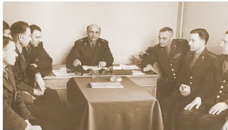
Начальник ОВПО по охране строительства Братской ГЭС проводит оперативное совещание с начсоставом отряда. Справа в центре — М.Н. Румянцев
