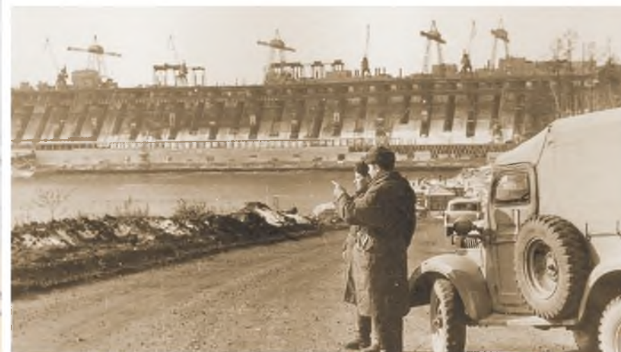
Оперативный дежурный ОВПО по охране строительства Братской ГЭС уточняет место для проведения учений по тактике, проводит оперативное совещание с начсоставом отряда. Справа в центре — М.Н. Румянцев
