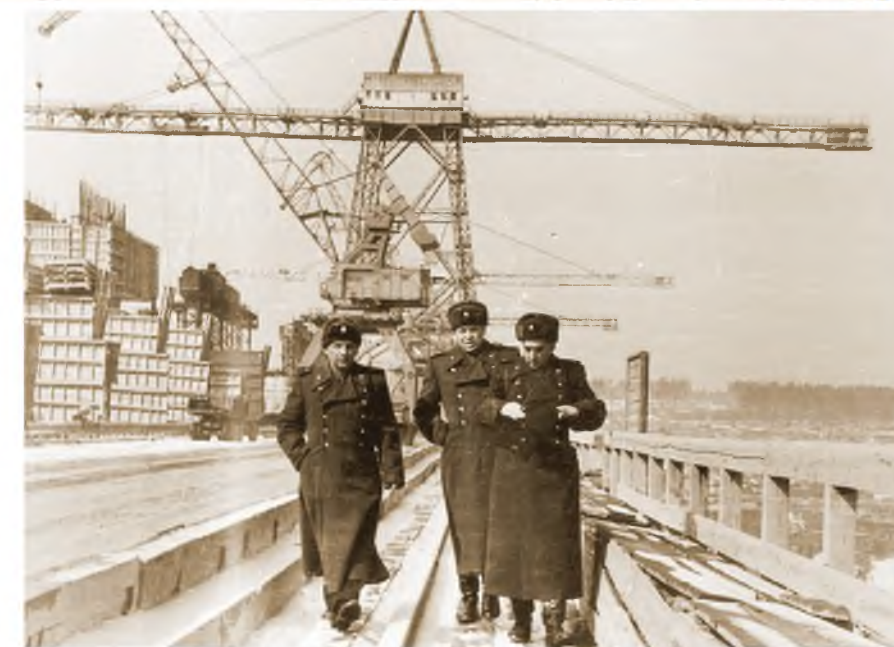
Строительство Братской ГЭС, 1962 г. Слева — начальник ОВПО по охране Братской ГЭС, майор М.А. Сурдул
